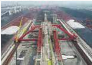
輸送設備安裝作業
