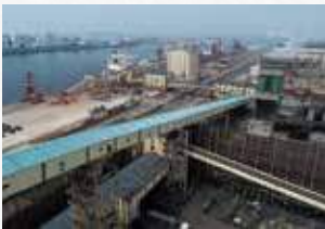
SCR設備安裝作業
