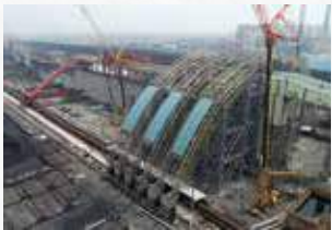
棚架安裝作業
